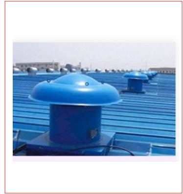
Roof Extractor Fan
