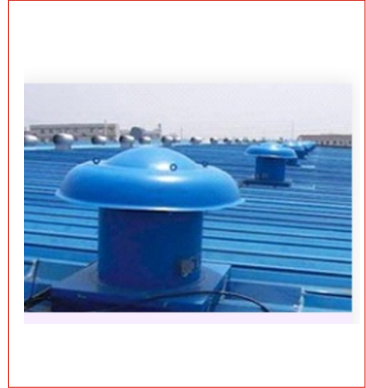
Roof Extractor Fan
